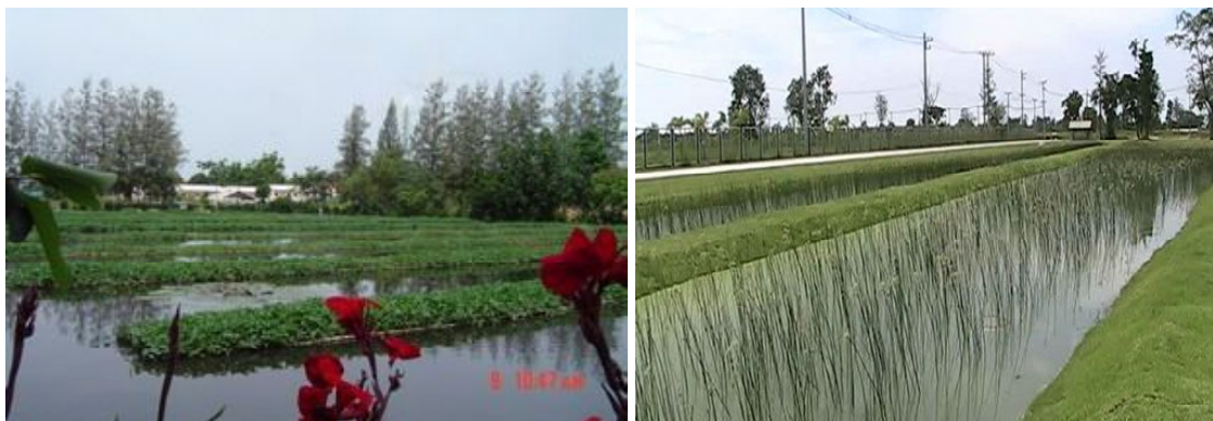
ภาพที่ 5 ระบบบึงประดิษฐ์แบบน้ำไหลบนผิวดินที่มีการประยุกต์ใช้งานจริง
