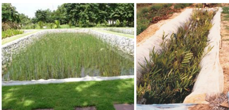
ภาพที่ 7 ระบบบึงประดิษฐ์แบบน้ำไหลใต้ผิวดินที่มีการนำไปประยุกต์ใช้งานจริง
