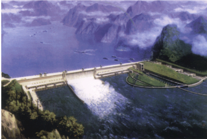
ภาพที่ 3 ภาพเขื่อนกันแม่น้ำแยงซีเกียง (Three gorges dam หรือ San Xia dam) เมื่อแล้วเสร็จในปี 2009
